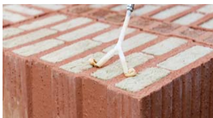
Technologie na lepidlo pro zdění Porotherm Dryfix.extra
