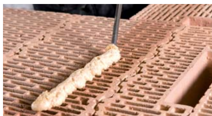
Technologie na zdicí pěnu Porotherm Dryfix
