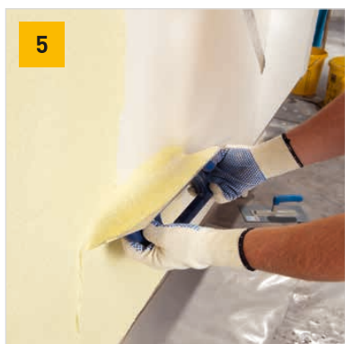
Nanášení finální vrstvy podle technologického předpisu výrobce
