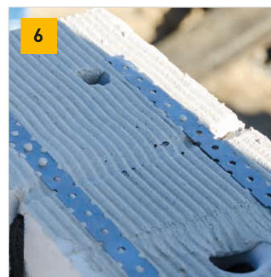
Spojování nosných stěn spojkami zdiva
