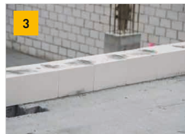
Detail založení zdiva pomocí tvárnice Silka 24 výšky 199 mm.
