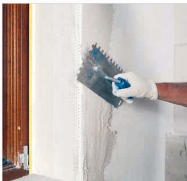
Instalace rohového profilu
