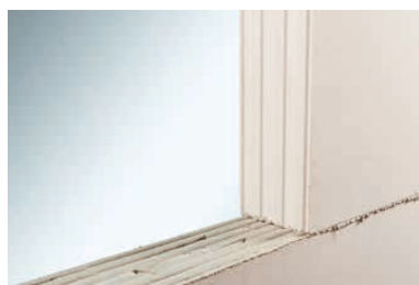
Uložení bloku do maltového lože
