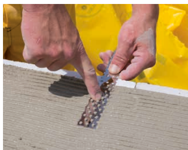
Průběžné vkládání spojky zdiva do ložné spáry
