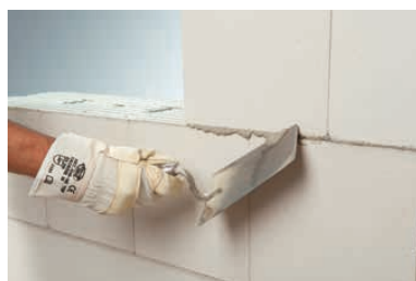
Po 24 hod odstranění přebytků zdicí malty
