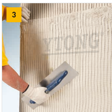
Vložení výztužné tkaniny Ytong
