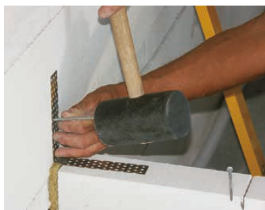
Dodatečná montáž spojky zdiva
