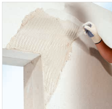
Provádění diagonální výztuže
