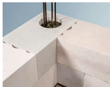
Vyzdění a vybetonované dvě vrstvy
