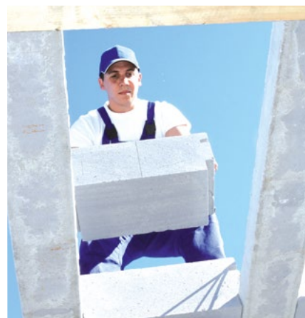
Ukládání stropních vložek
